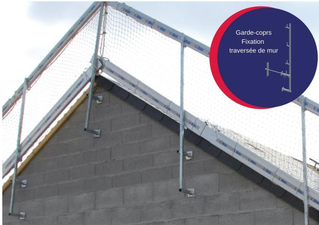
Die Schutzgeländer werden an der Dachkante oder am unteren Dachende befestigt und beinhalten das Sicherheitszubehör (Abschlussleisten, Fußleisten, Netze), um einen vollständigen Schutz zu gewährleisten.
